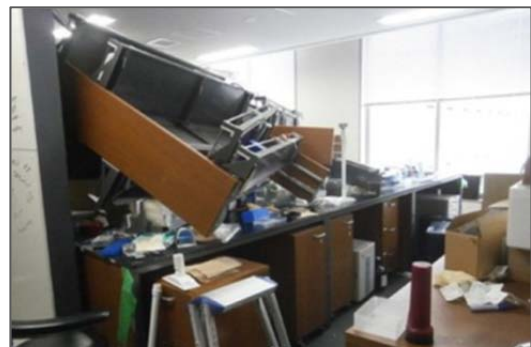
実験棚の倒壊。実験台にボルト固定されていたが棚の表面がはく離したことにより倒壊。
